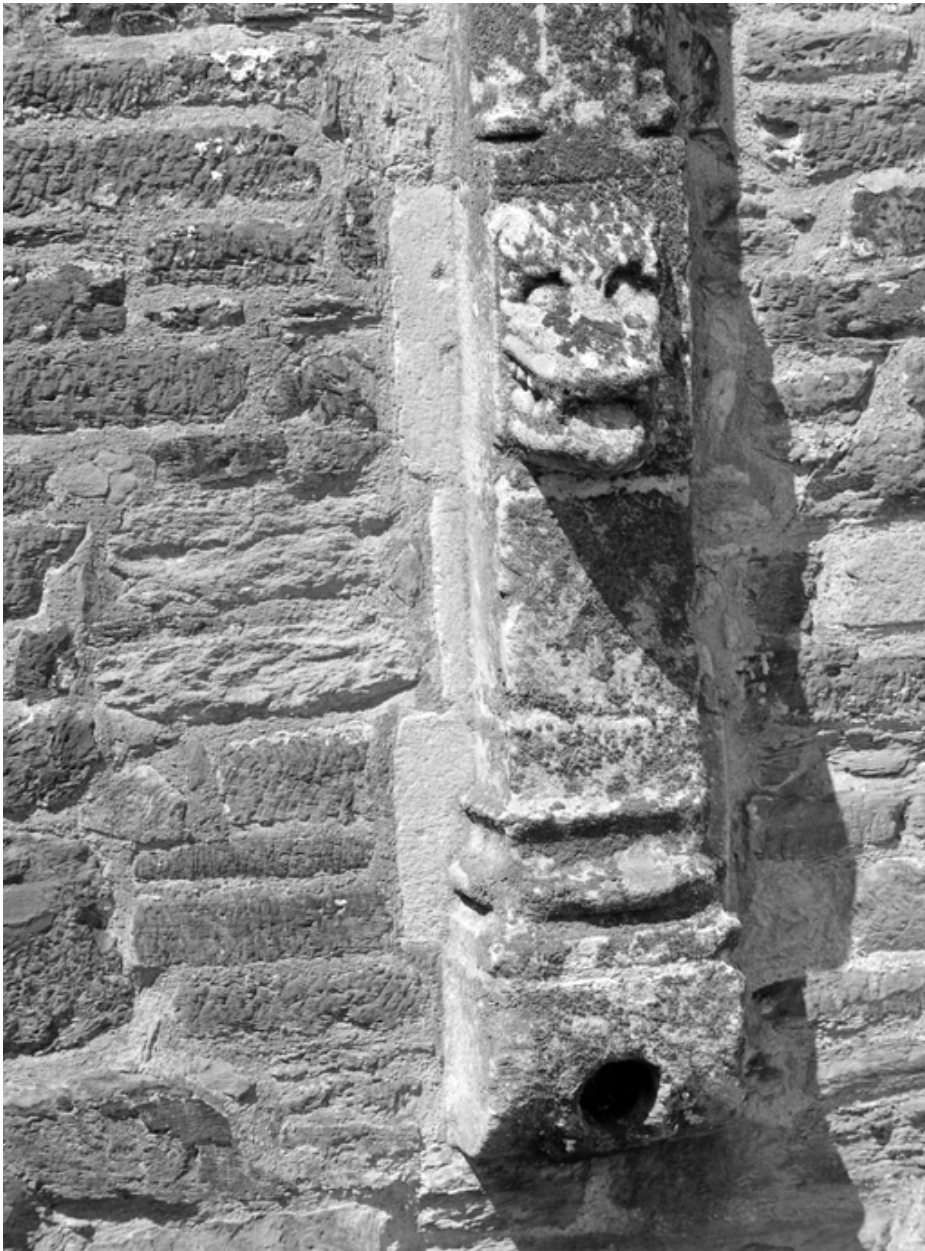
Aile nord, côté cour : deuxième tuyau de descente
