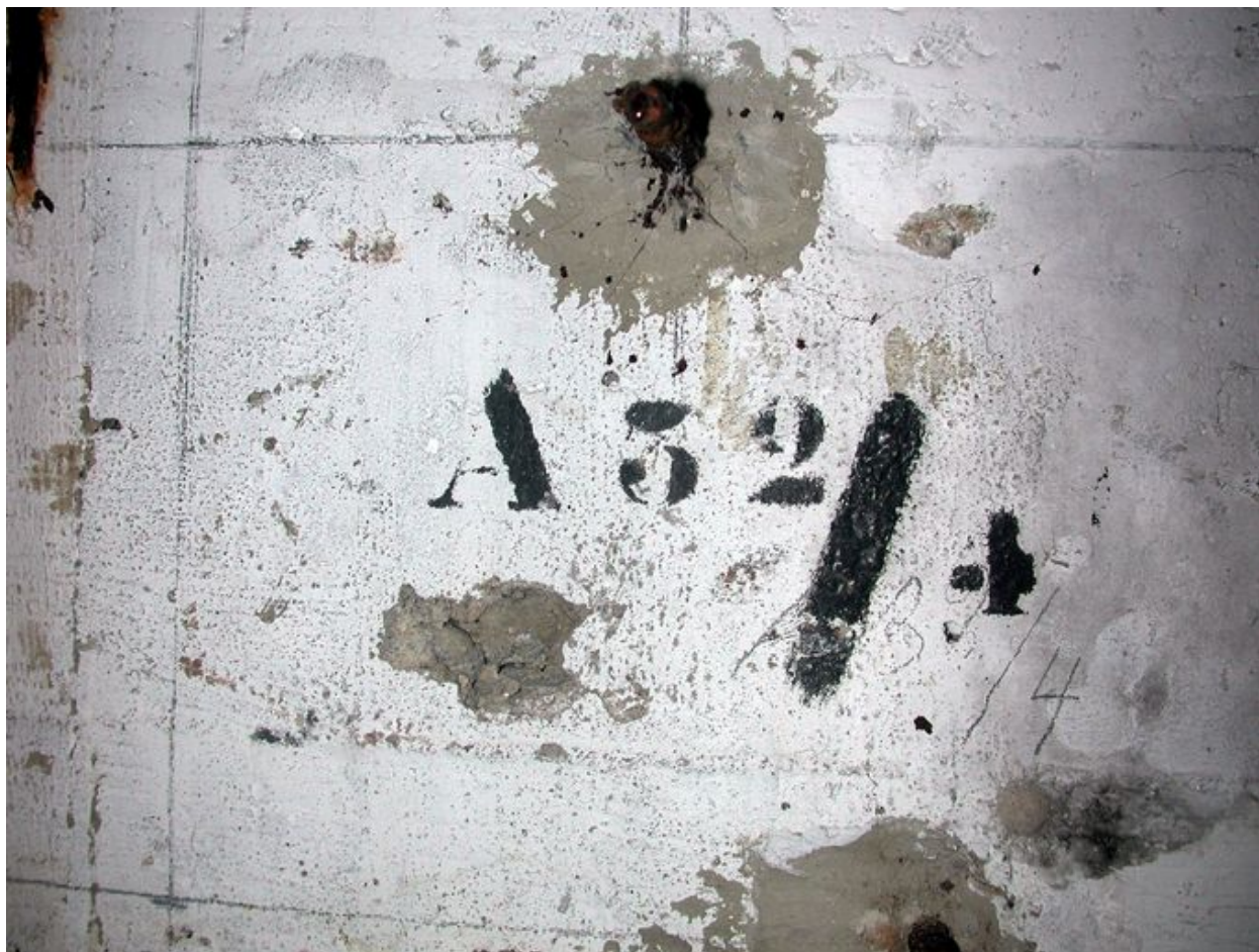
Vue du marquage de l'ensemble fortifié et du bunker (état en 2003)
