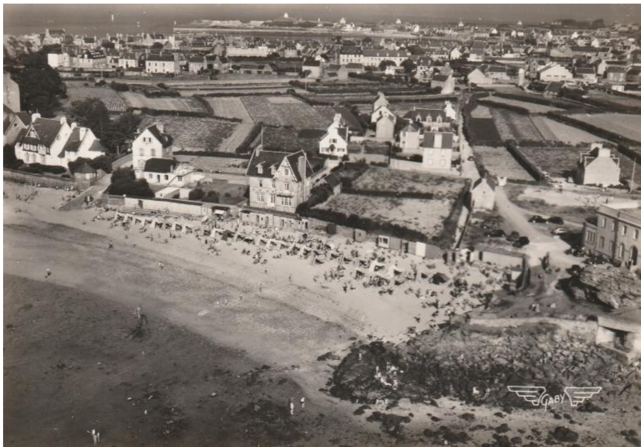
Vue aérienne oblique de l'Institut marin à Roscoff, établissement de thalassothérapie et de la plage de Roc'h Kroum, carte postale (éditions Gaby). En bas, à l'extrême droite : le bunker - casemate de type 676 implanté au pied du chaos granitique
