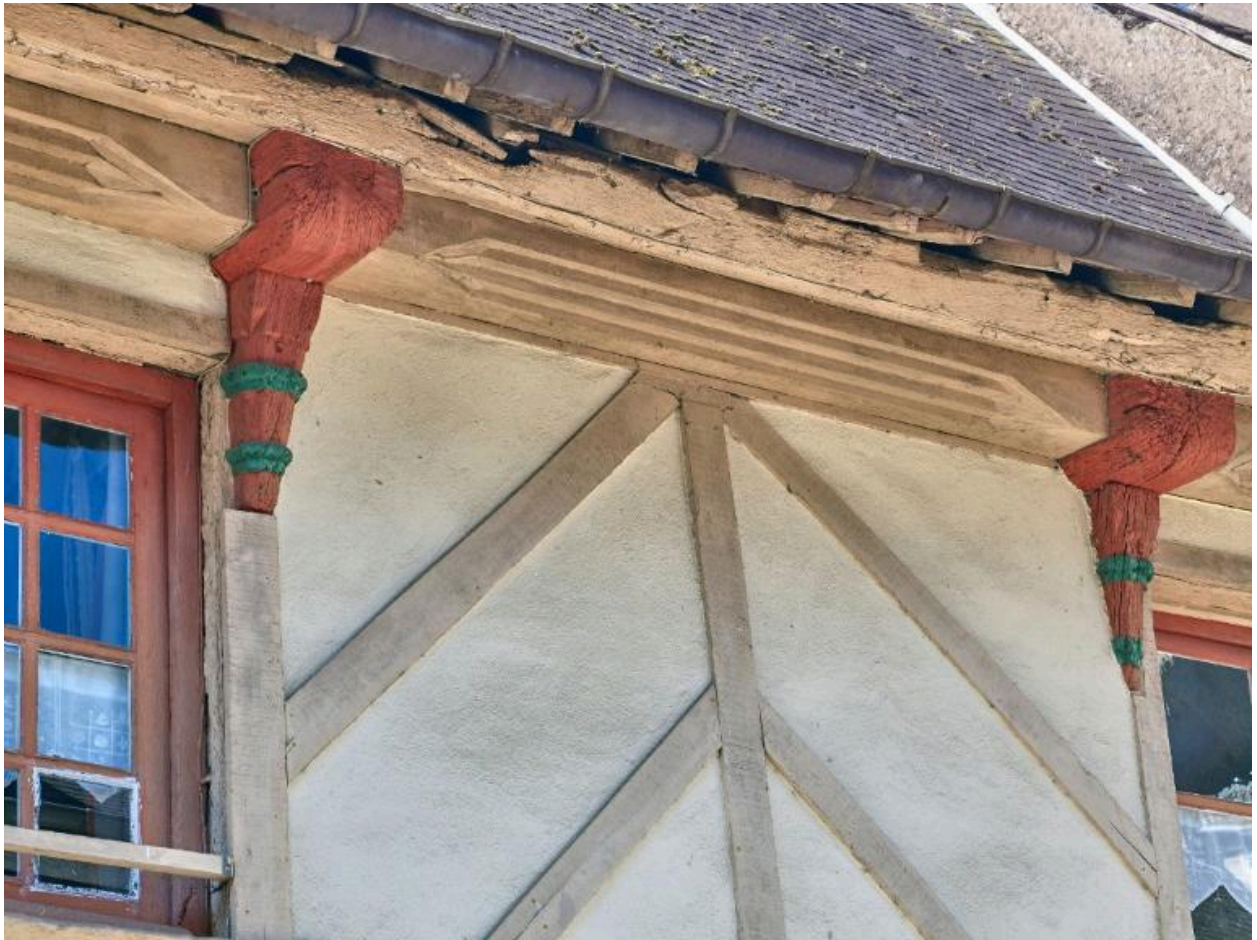
Faux pan de bois et entretoises refaites sous la toiture.
