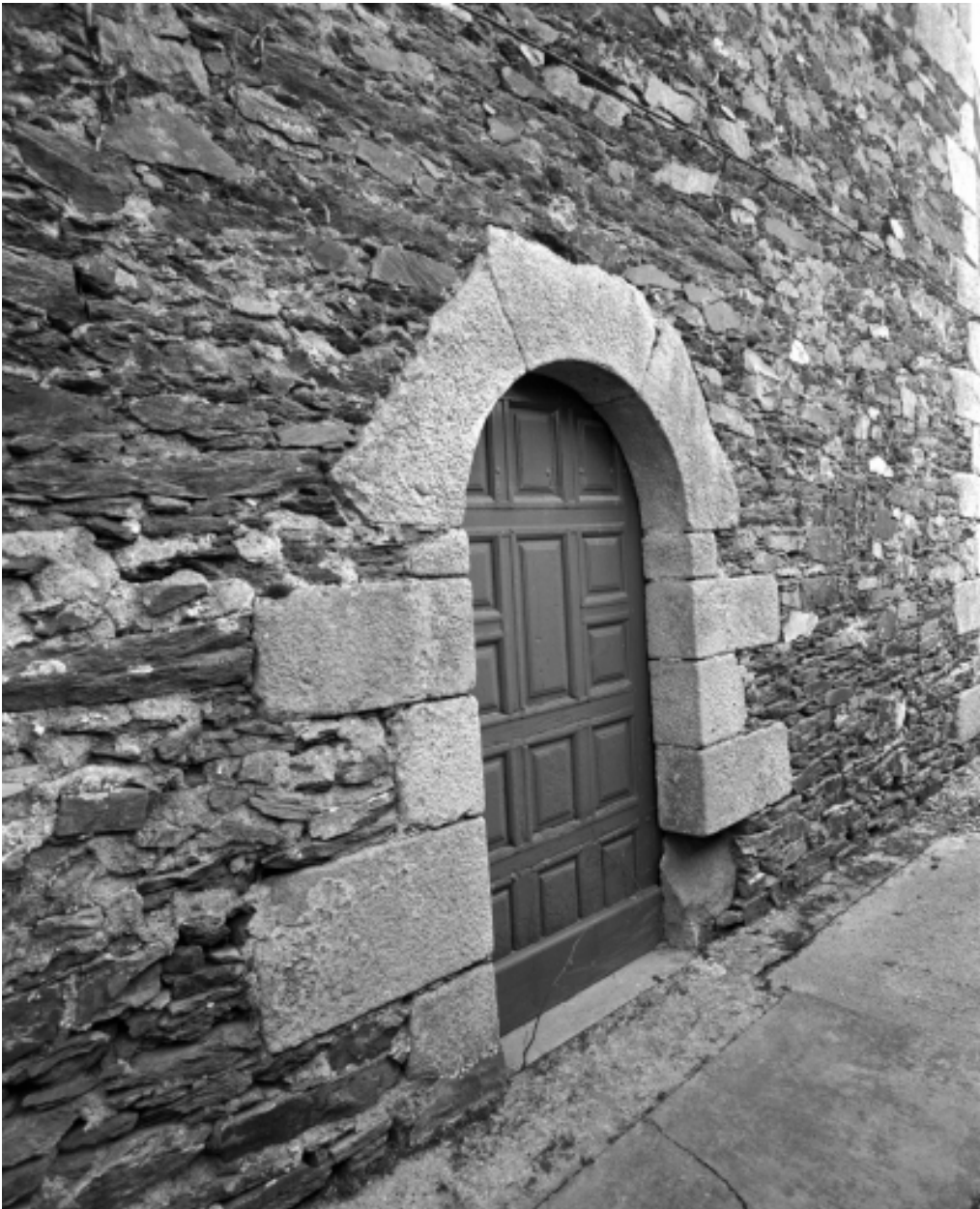
Elévation sud ouest, porte ; vue générale
