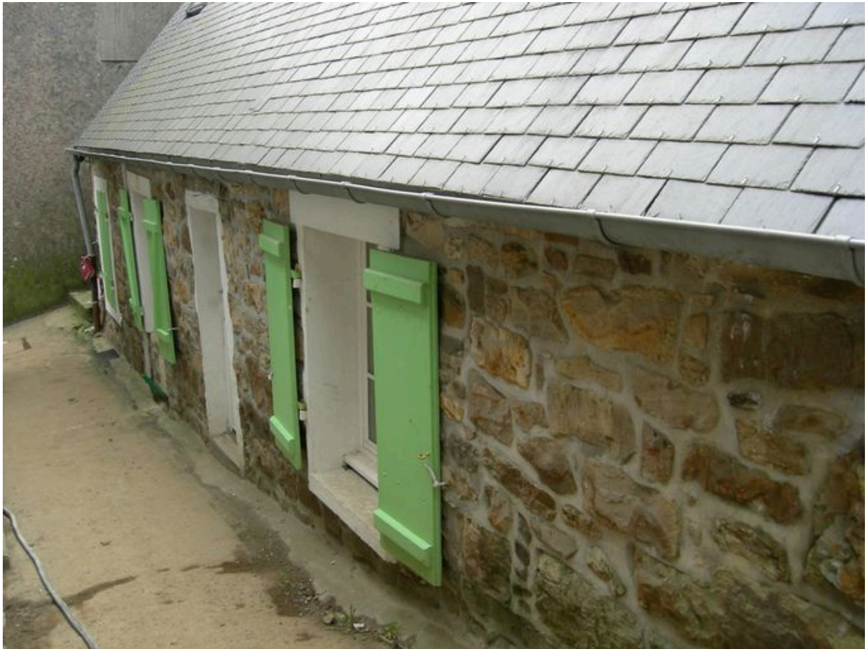
Vue générale de la maison de la venelle de Bel-Air
