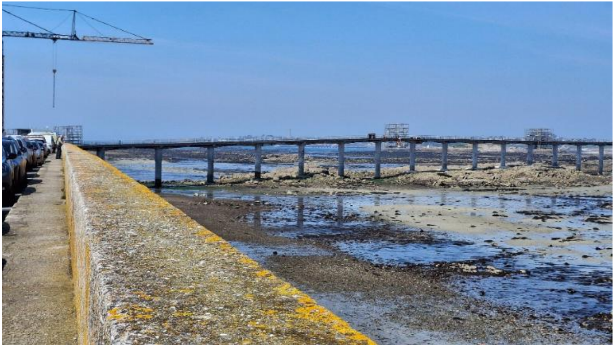
Parapet du nouveau quai et estacade
