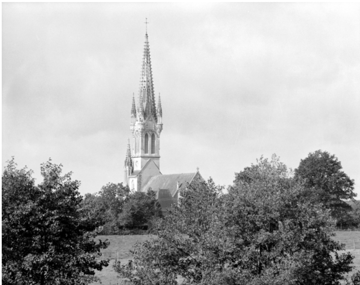
Vue de situation sud-ouest.
