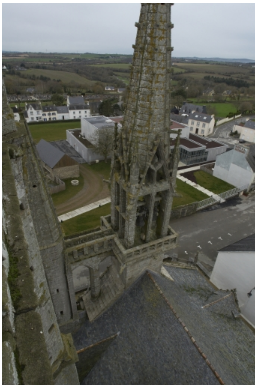
Elévation ouest, détail de la galerie liant la tour d'escalier au clocher, vue depuis le haut de la tour-porche
