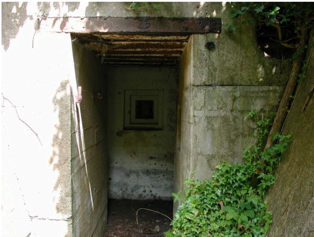
Landéda, île Cézon : abri pour un groupe de type 501 du fort Cézon, vue de l'entrée flanquée d'un créneau blindé de défense
