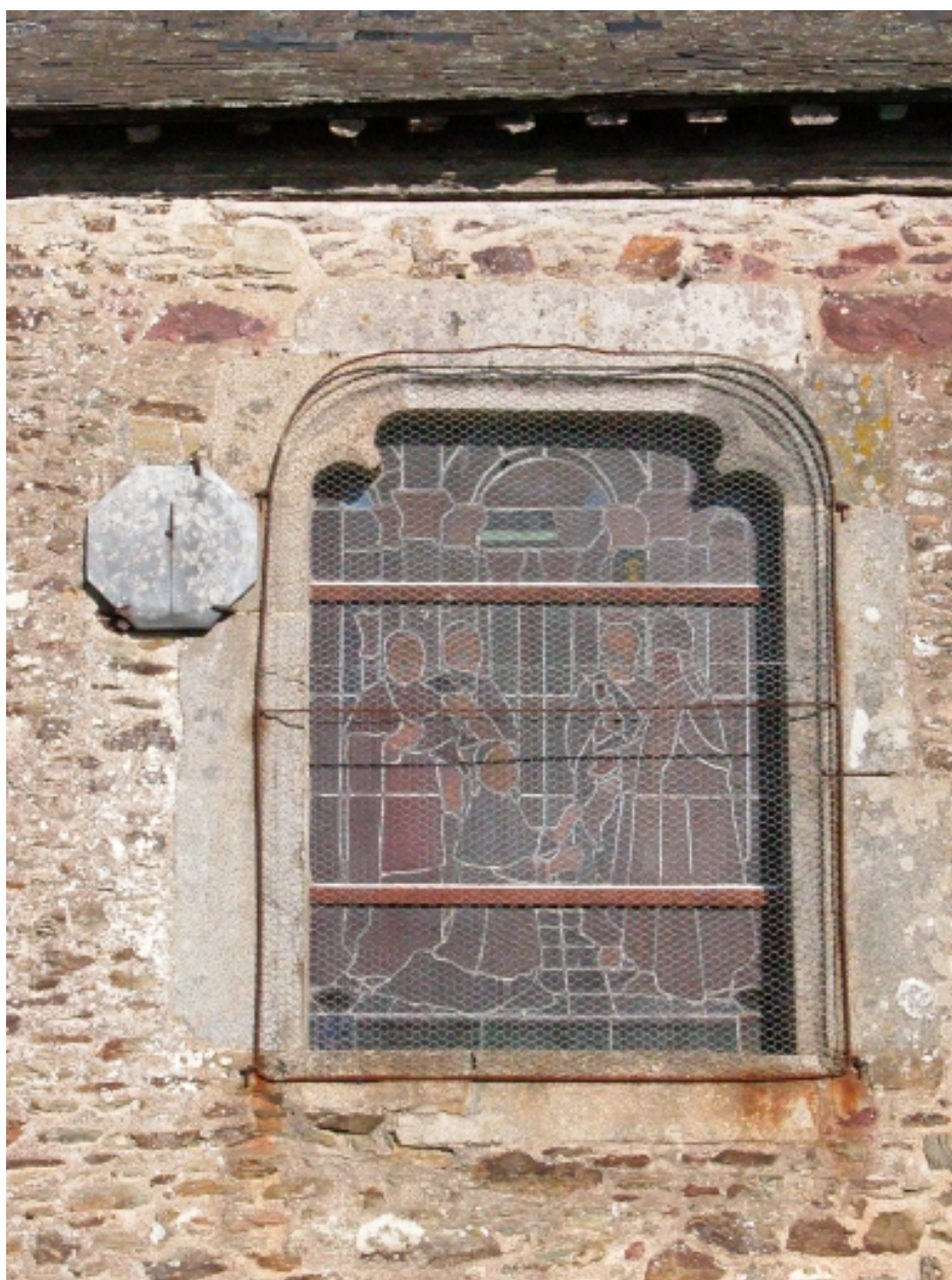
Fenêtre de la nef
