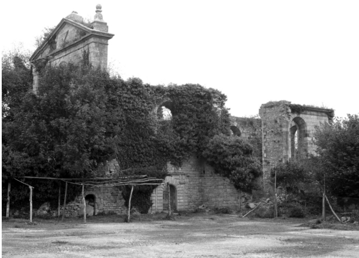
Chapelle : vue générale, sud-ouest
