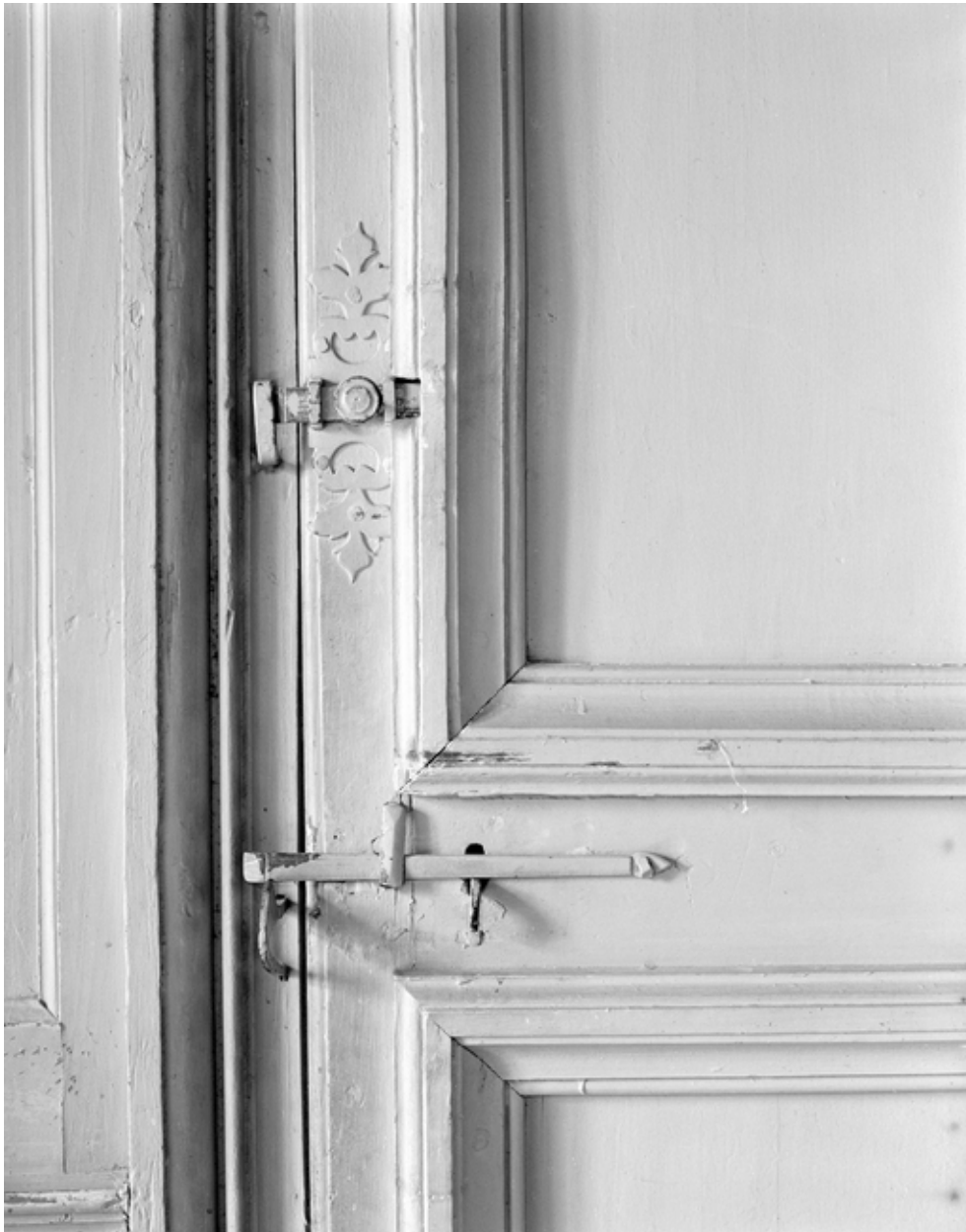
Premier étage, grande chambre sud, détail de la porte de la garde-robe.
