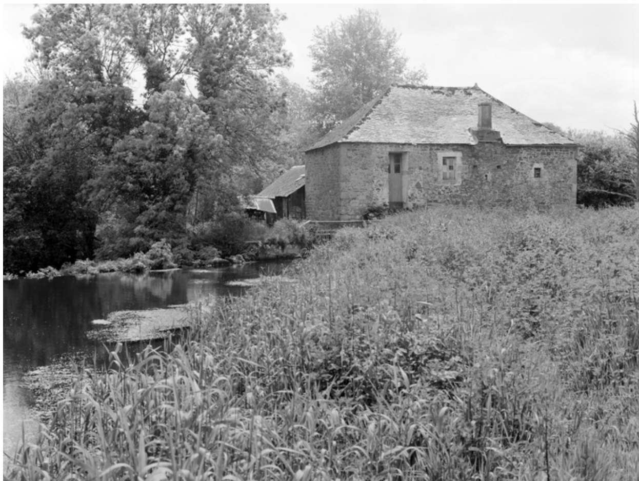
Vue amont du bief.
