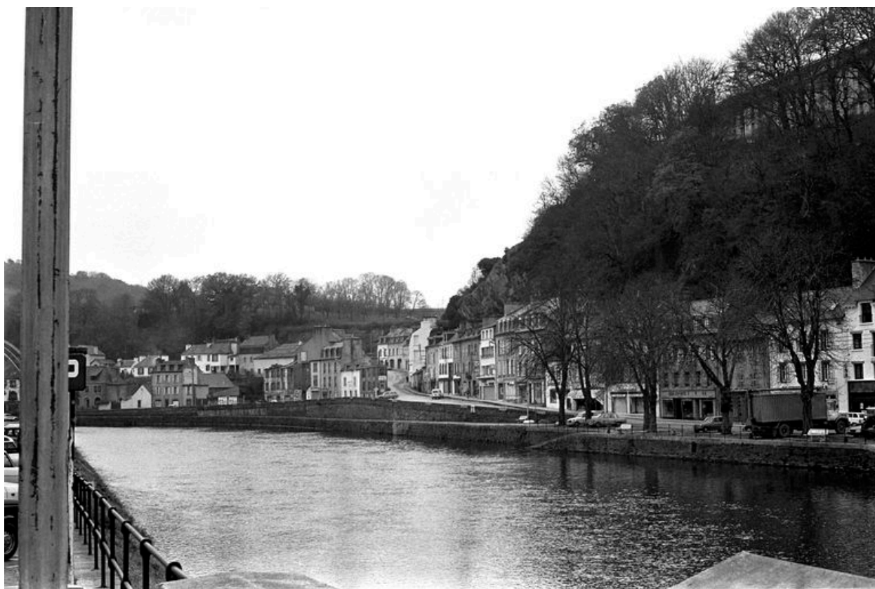
Quai Carnot : vue générale
