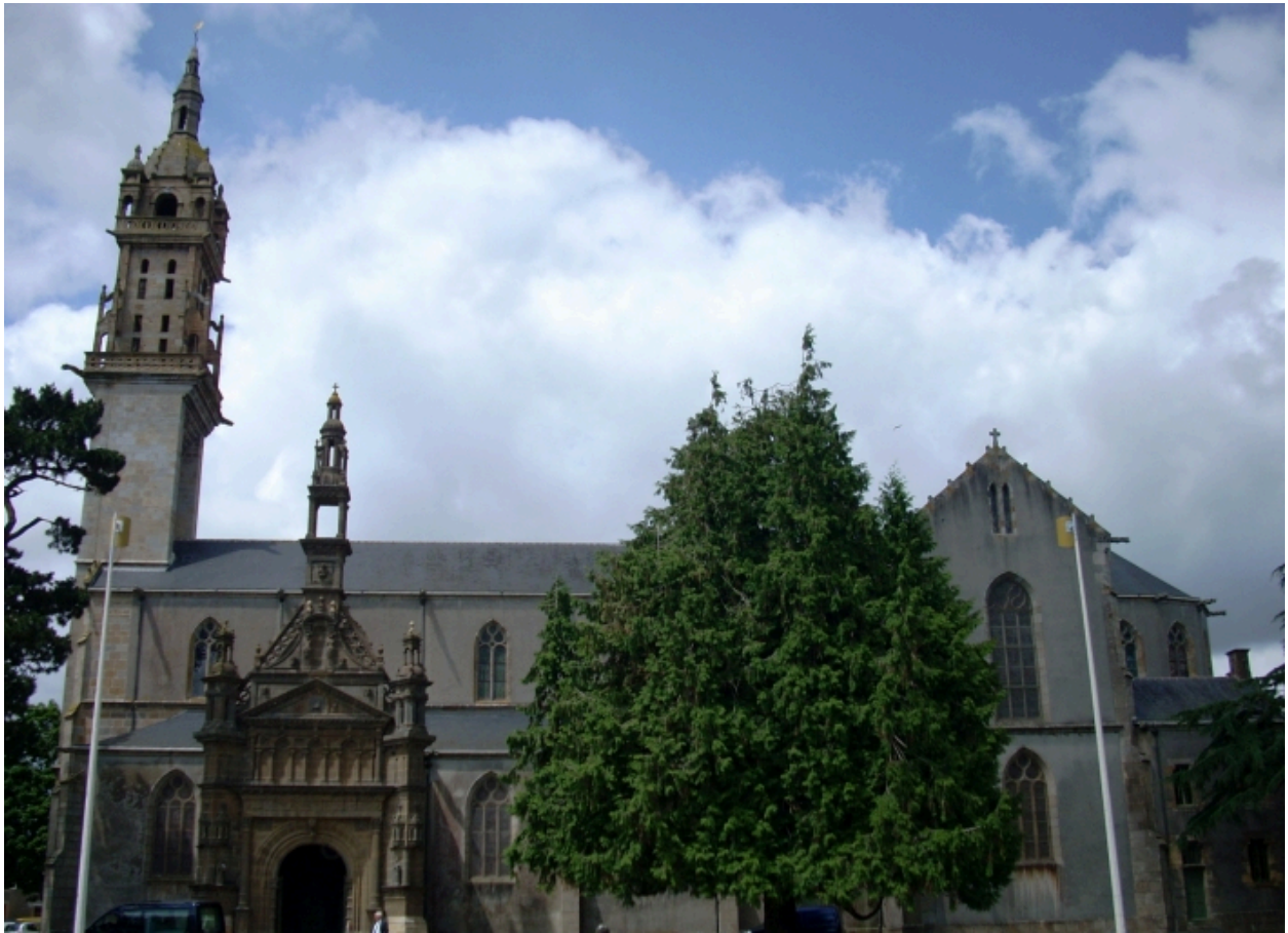
Landerneau, église Saint-Houardon : élévation sud
