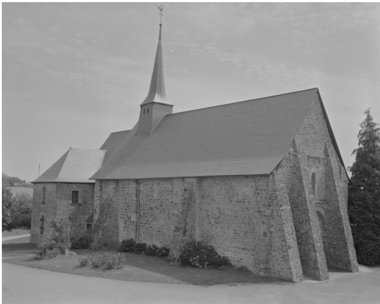
Elévation nord-ouest : vue générale
