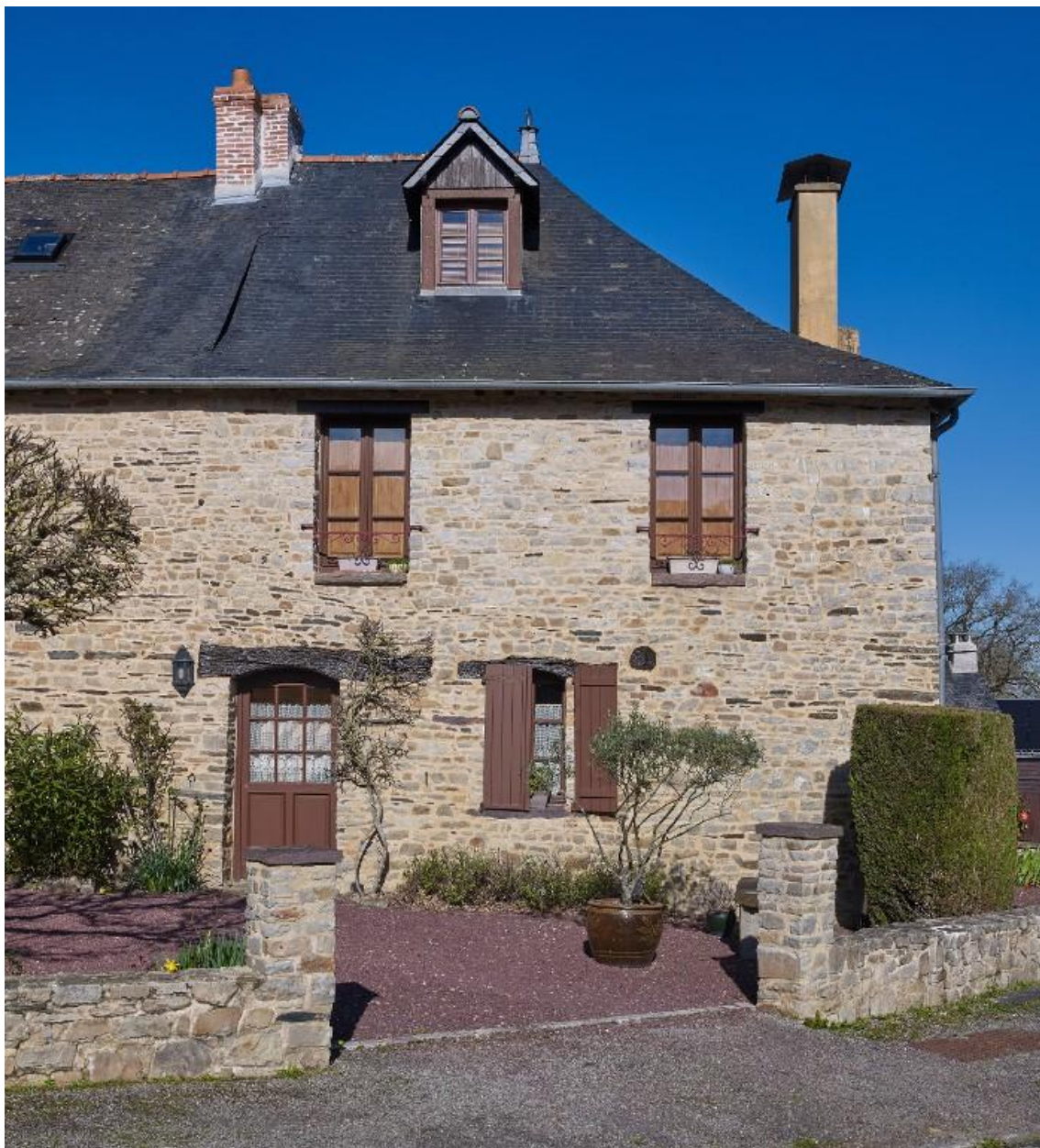
Façade sur rue de la maison, 7 rue de Choisel
