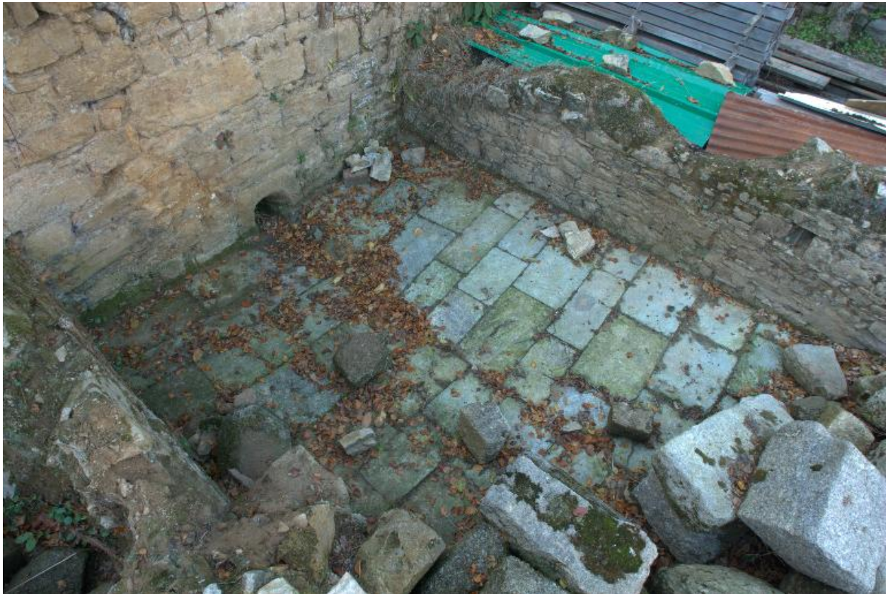
Vue intérieure du corps de bâtiment sud-ouest adossé contre la courtine : salle pavée et dotée d'un égout en rez-de-cour, il s'agit d'une souillarde (arrière-cuisine)
