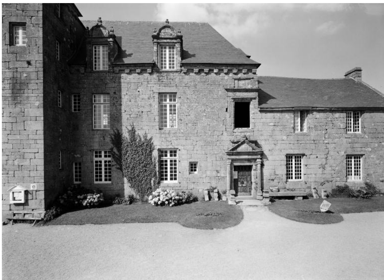
Vue d'ensemble façade sud des parties centrales et est du bâtiment
