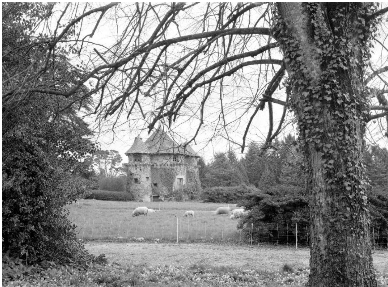
Château, tour nord-est, vue générale.
