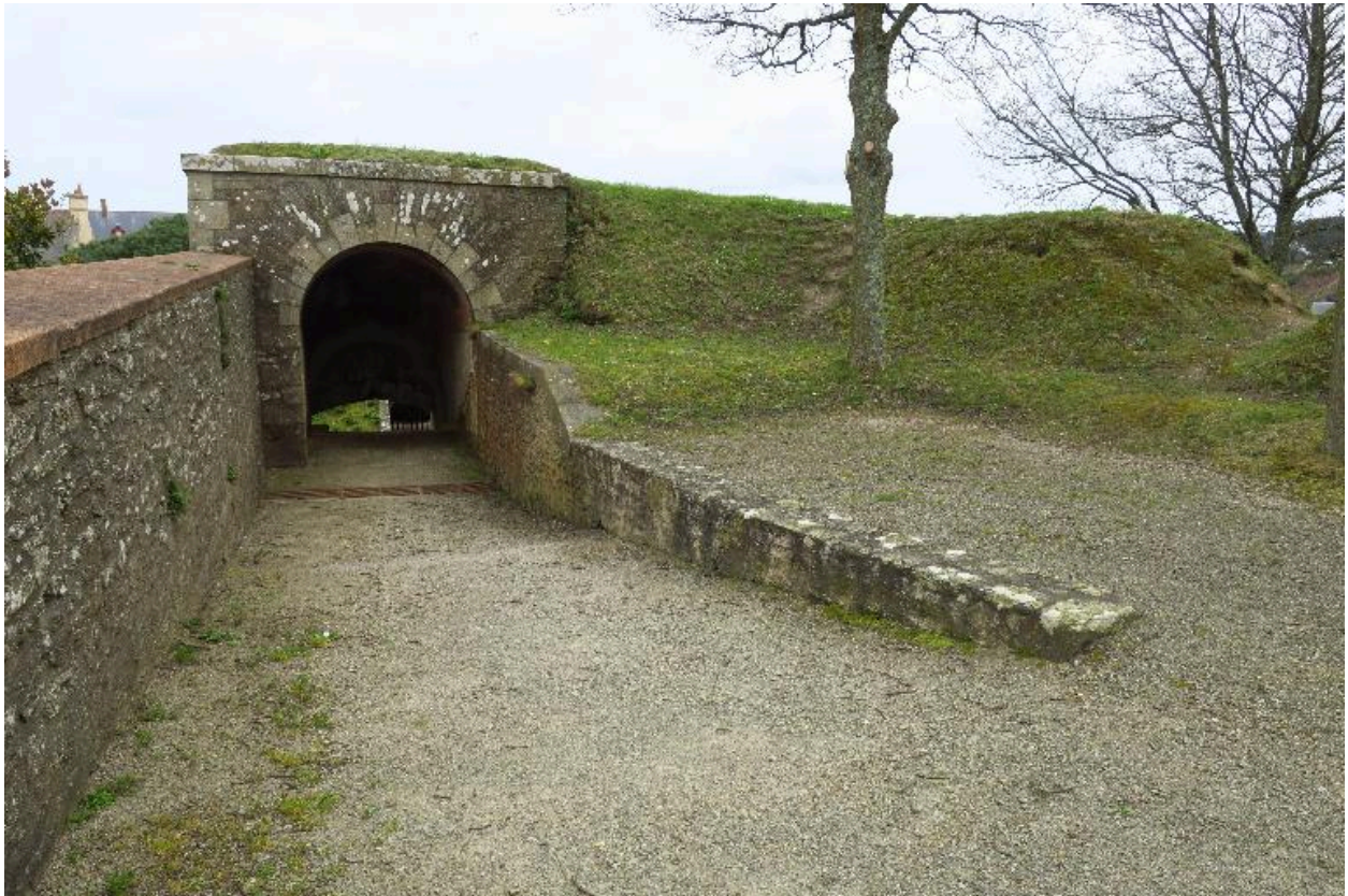
Le Palais, citadelle, cavalier du bastion 2, débouché supérieur de l'escalier-rampe.
