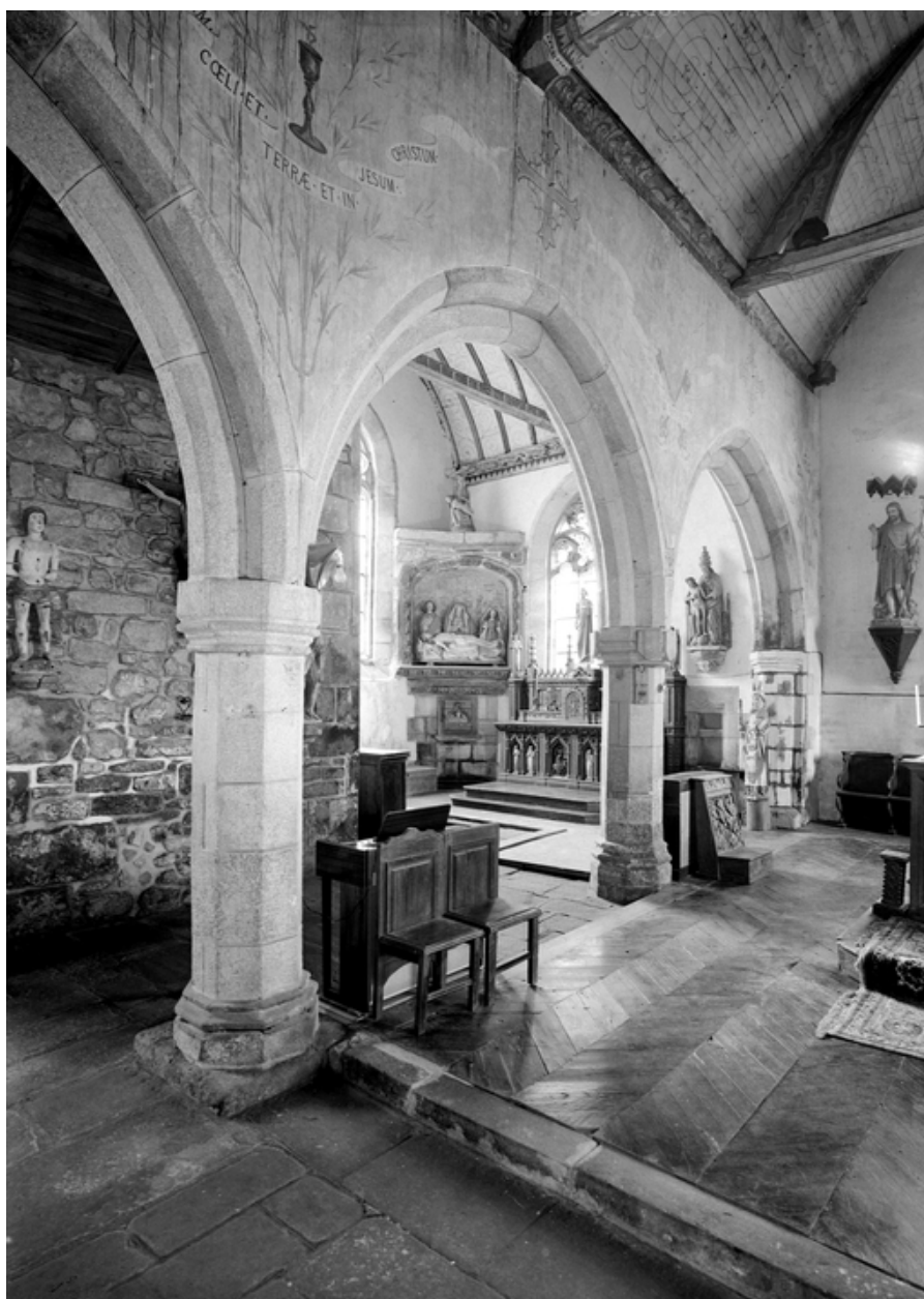
Vue diagonale du bras nord du transept prise de la nef
