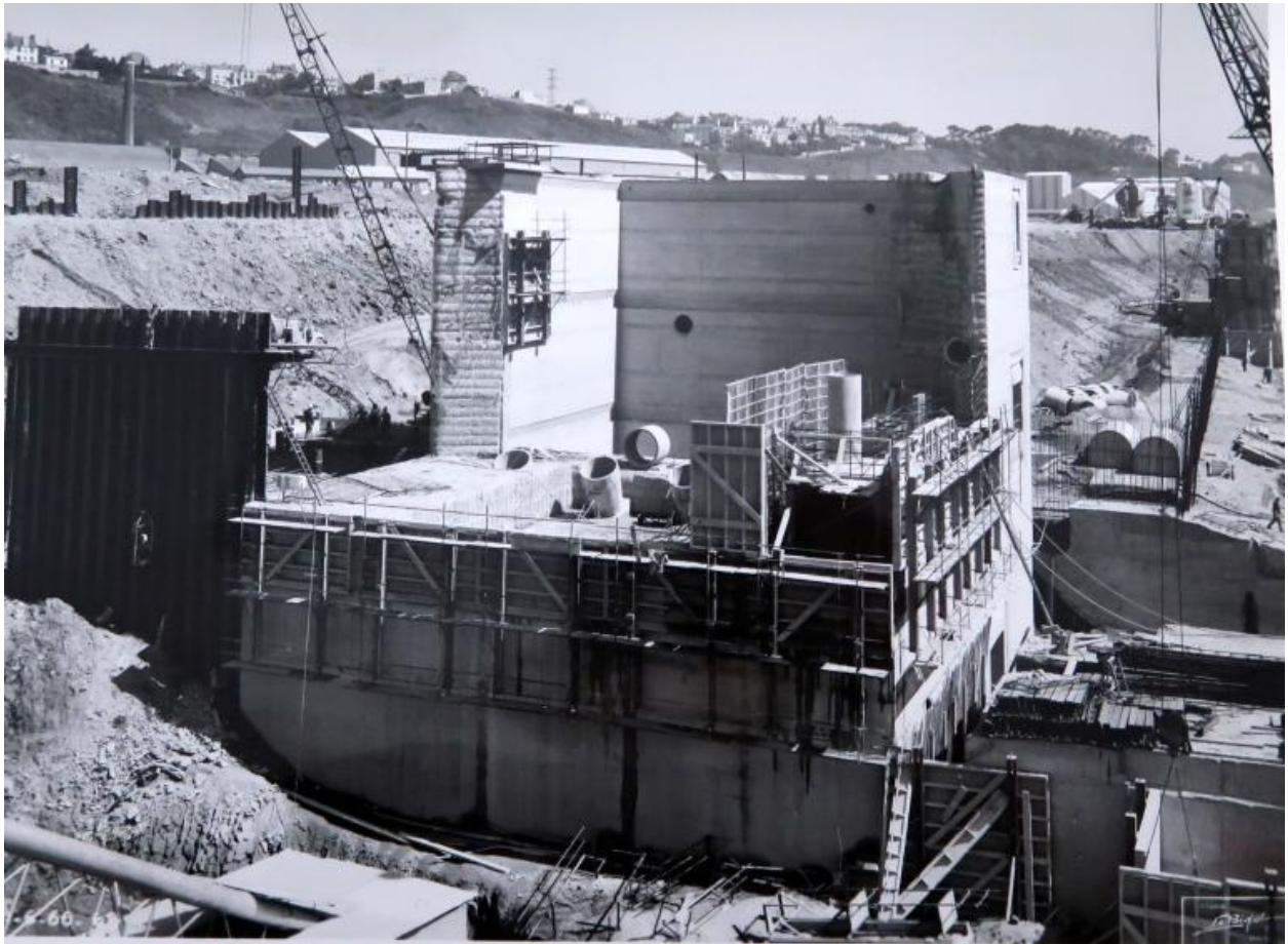
Travaux de construction de la forme 2 : construction de la station de pompage (03/06/1966)
