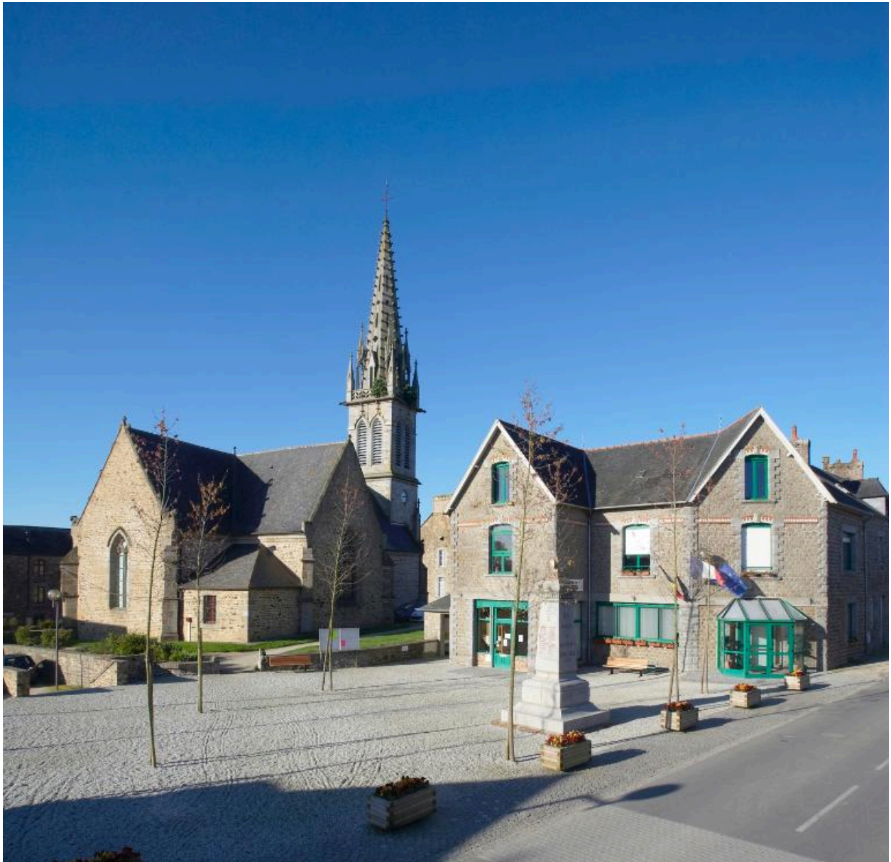
Vue générale : côté Nord-Est (mairie au premier plan)
