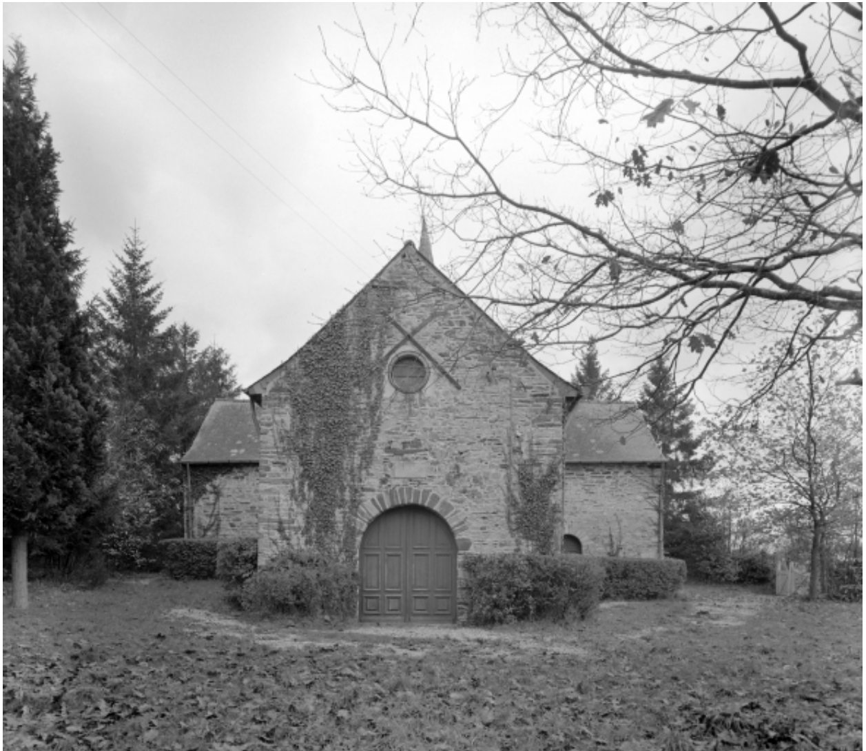
Elévation Ouest : vue générale
