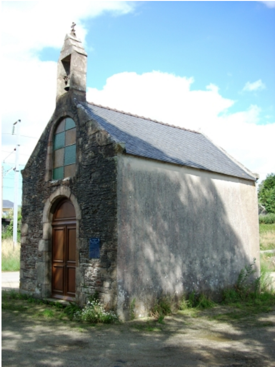
Plouigneau, chapelle Saint-Divy : vue générale sud-ouest
