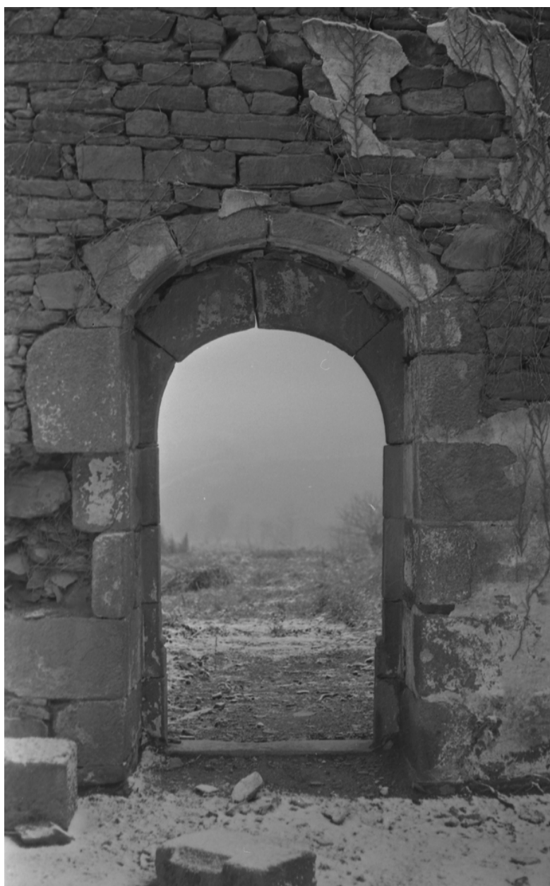
Porte ouest, vue prise de l'intérieur de la nef
