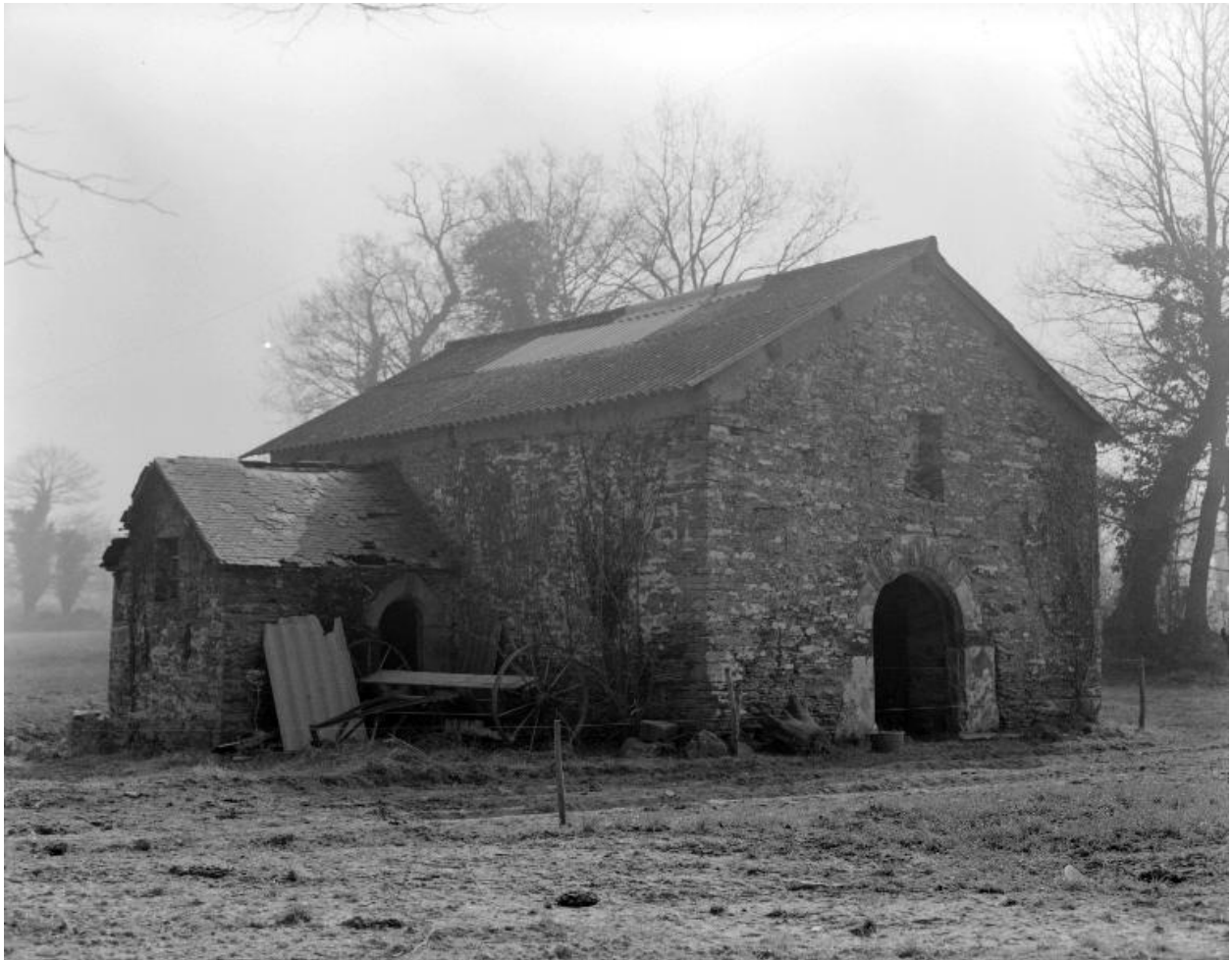
Manoir, chapelle : vue générale nord-ouest (état en 1984)
