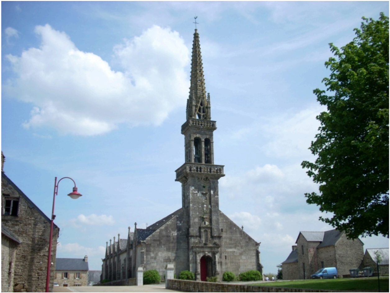
Plouyé, église paroissiale Saint-Joseph : vue générale nord-ouest
