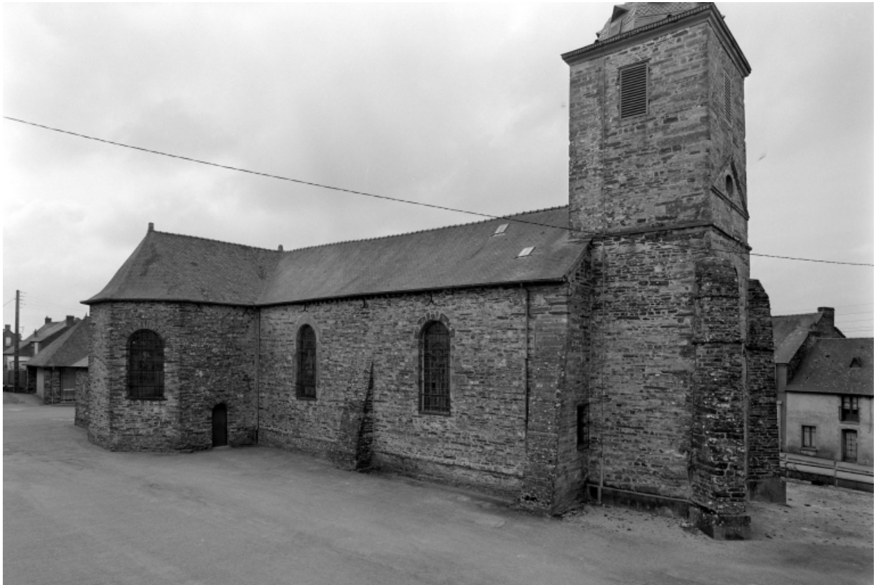
Elévation Nord : vue générale
