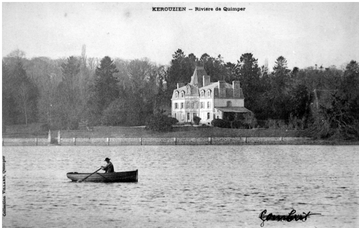
Vue latérale depuis la rivière de Quimper
