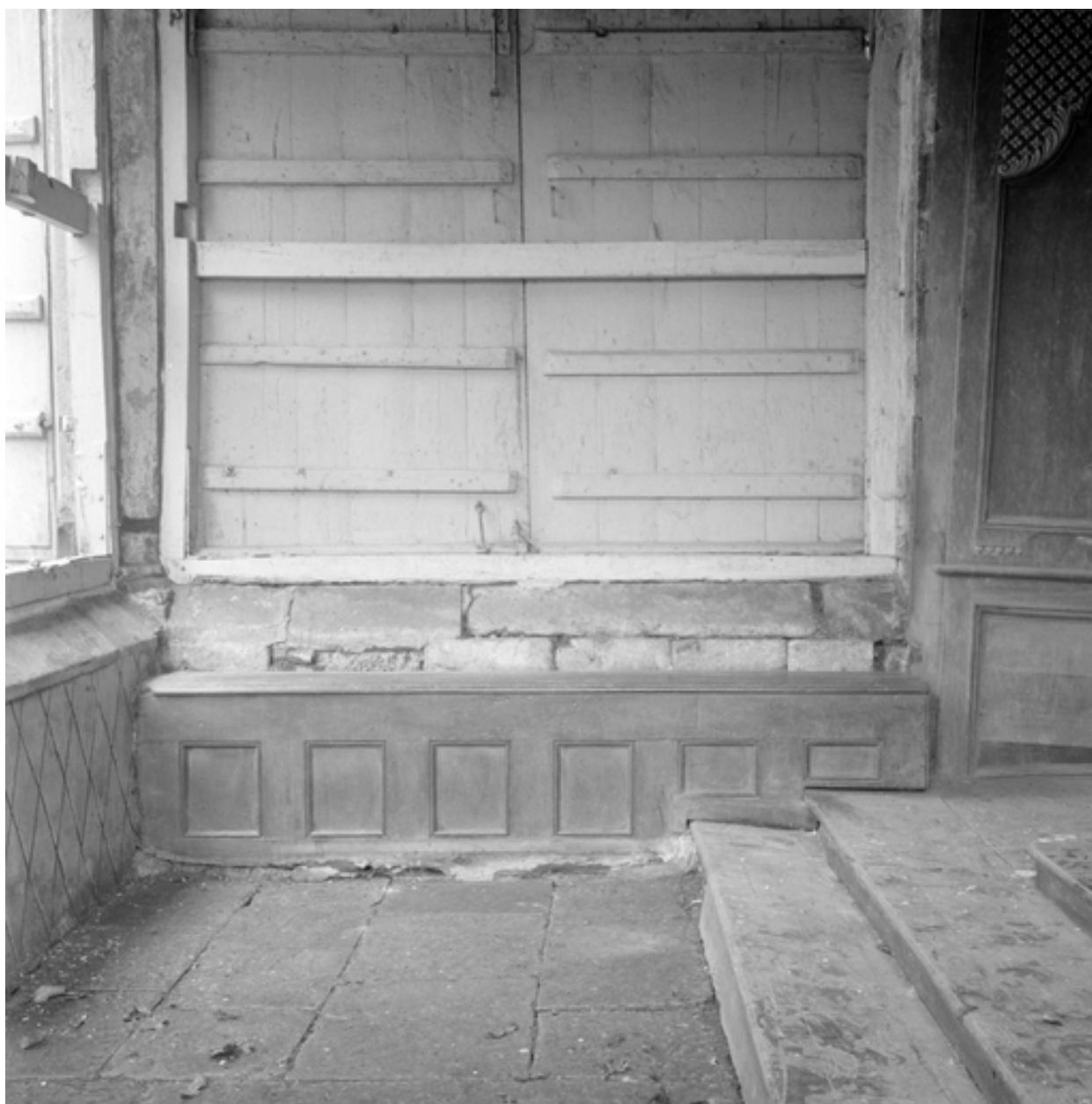
Oratoire : banc de bois contre le mur nord.
