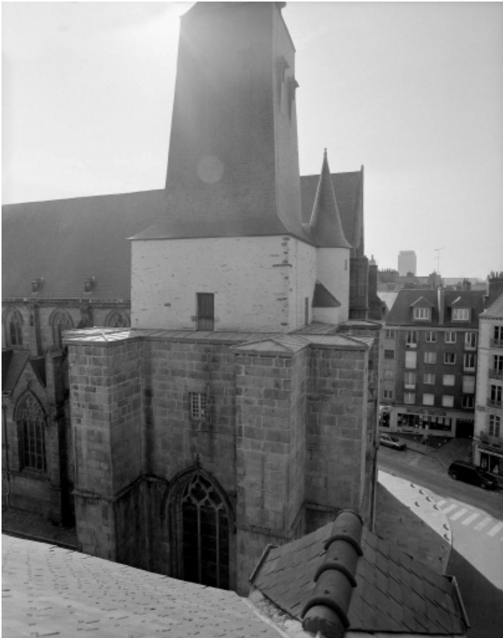
Elévation nord, clocher : vue générale
