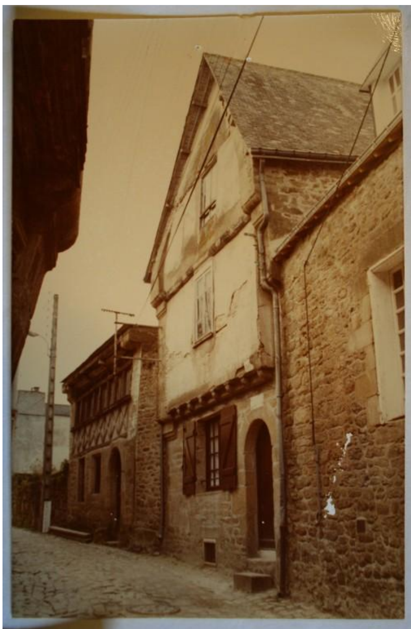
Maison du 4 rue du Petit Port avant sa restauration au début des années 1980.
