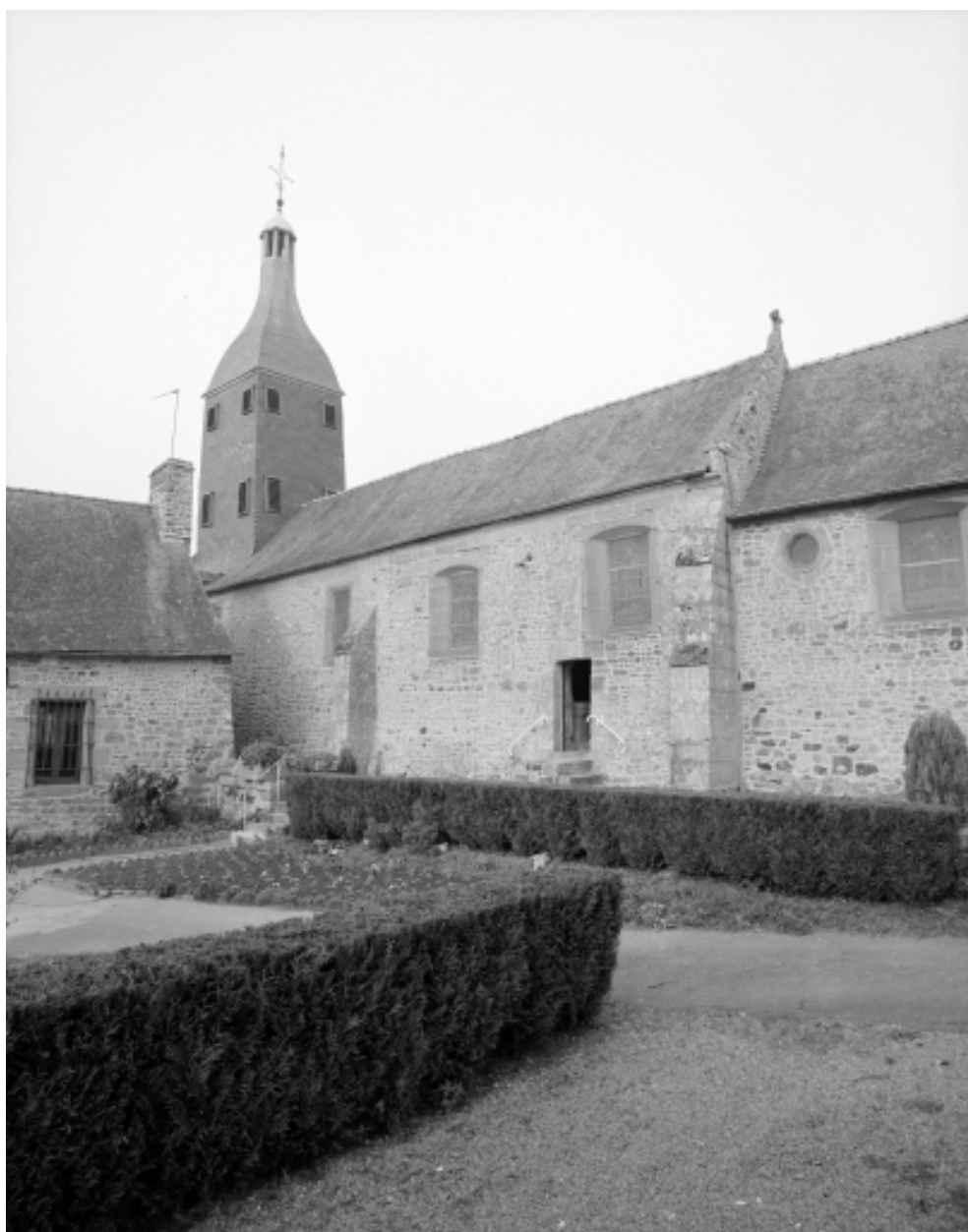
Elévation Sud-Ouest : vue générale
