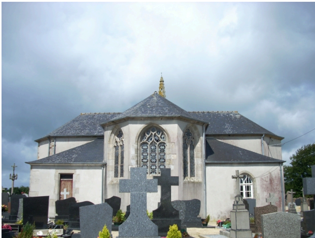
Saint-Derrien, église paroissiale Saint-Derrien : élévation est
