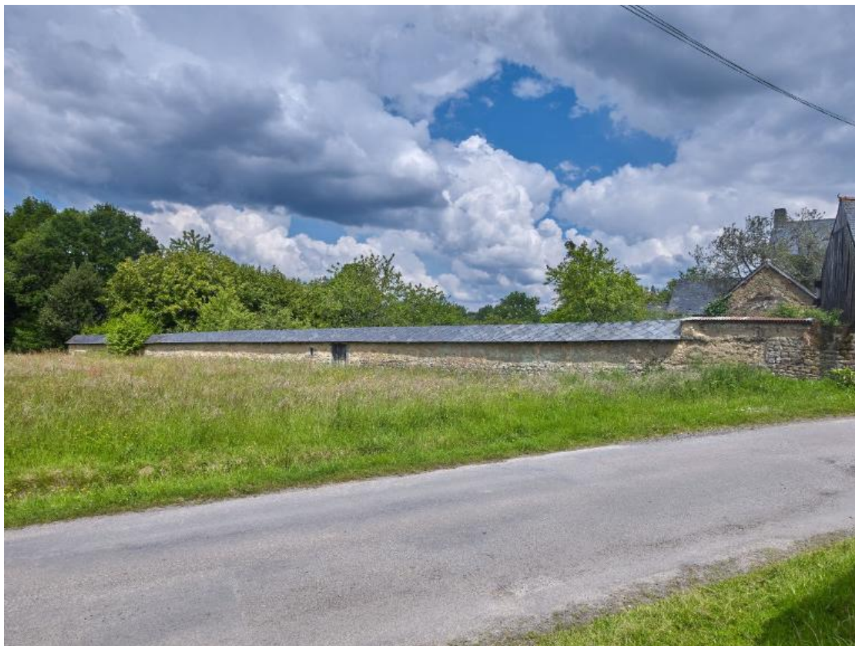
Mur de clôture de l'ancien presbytère
