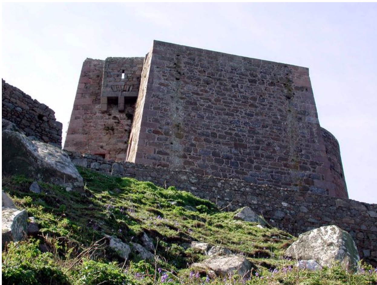
Vue de la redoute, réduit de l'île aux Moines depuis le nord
