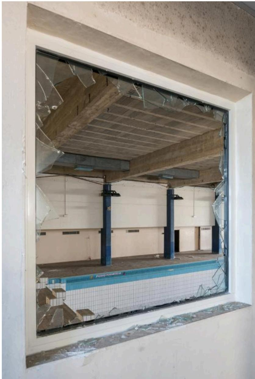
Vue sur le bassin de la piscine et la structure poteaux poutres en béton armé. Jean de Jaegher et François Rousseau, architectes, 1968.
