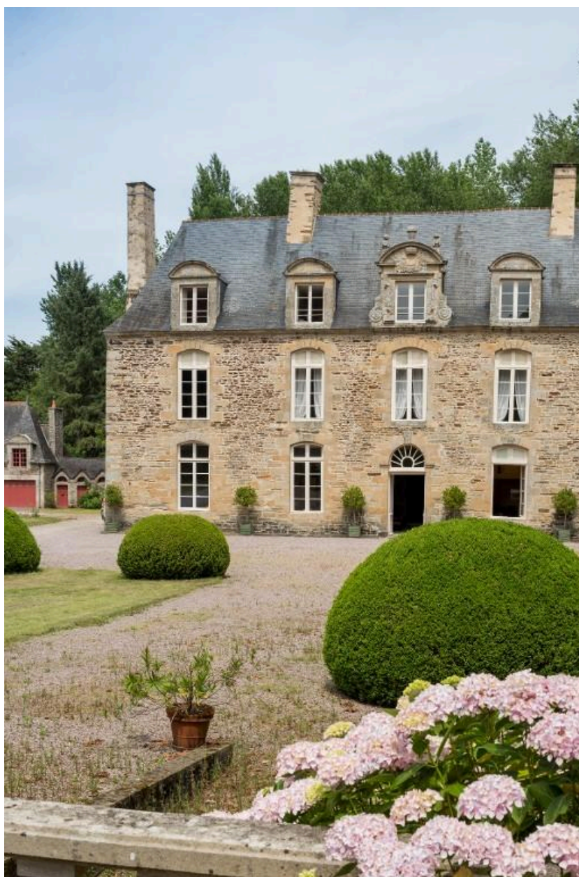
Vue générale de la façade sud
