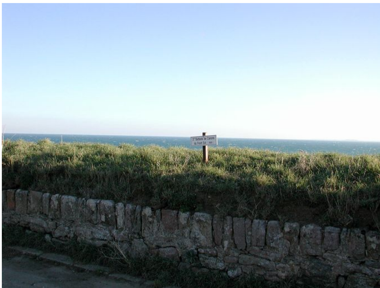
Vue du Fort La Latte
