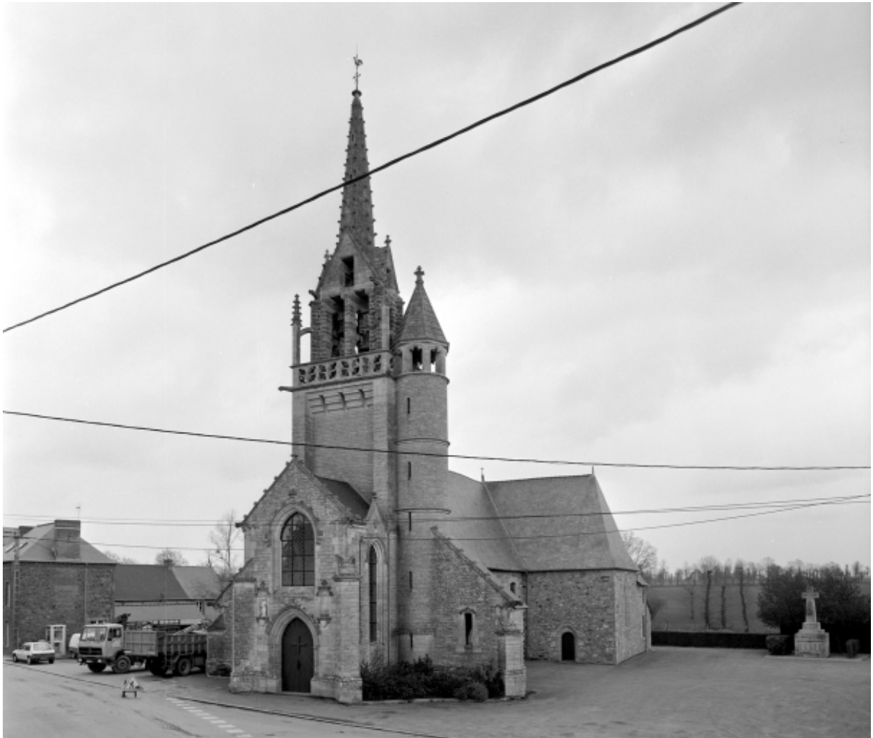
Elévation Ouest : vue générale
