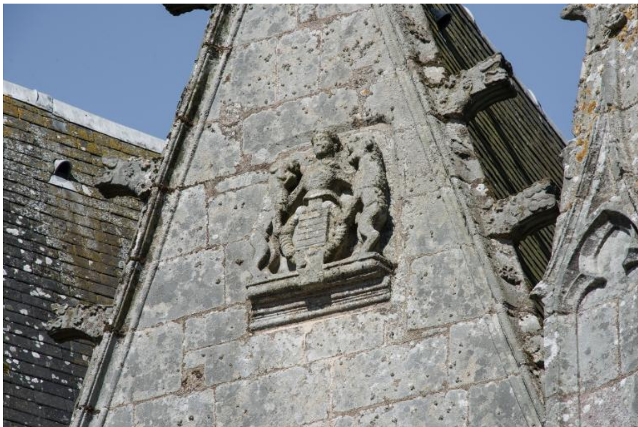
Vue de détail : armoiries sur un des pignons du chevet.
