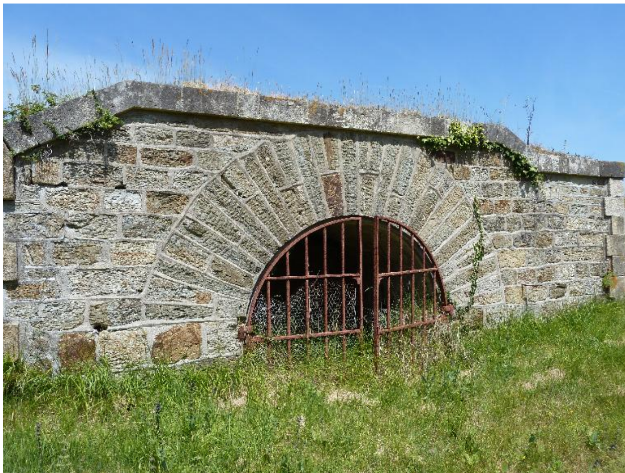
Le Palais, batterie du Gros Rocher, traverse et niche à munitions.
