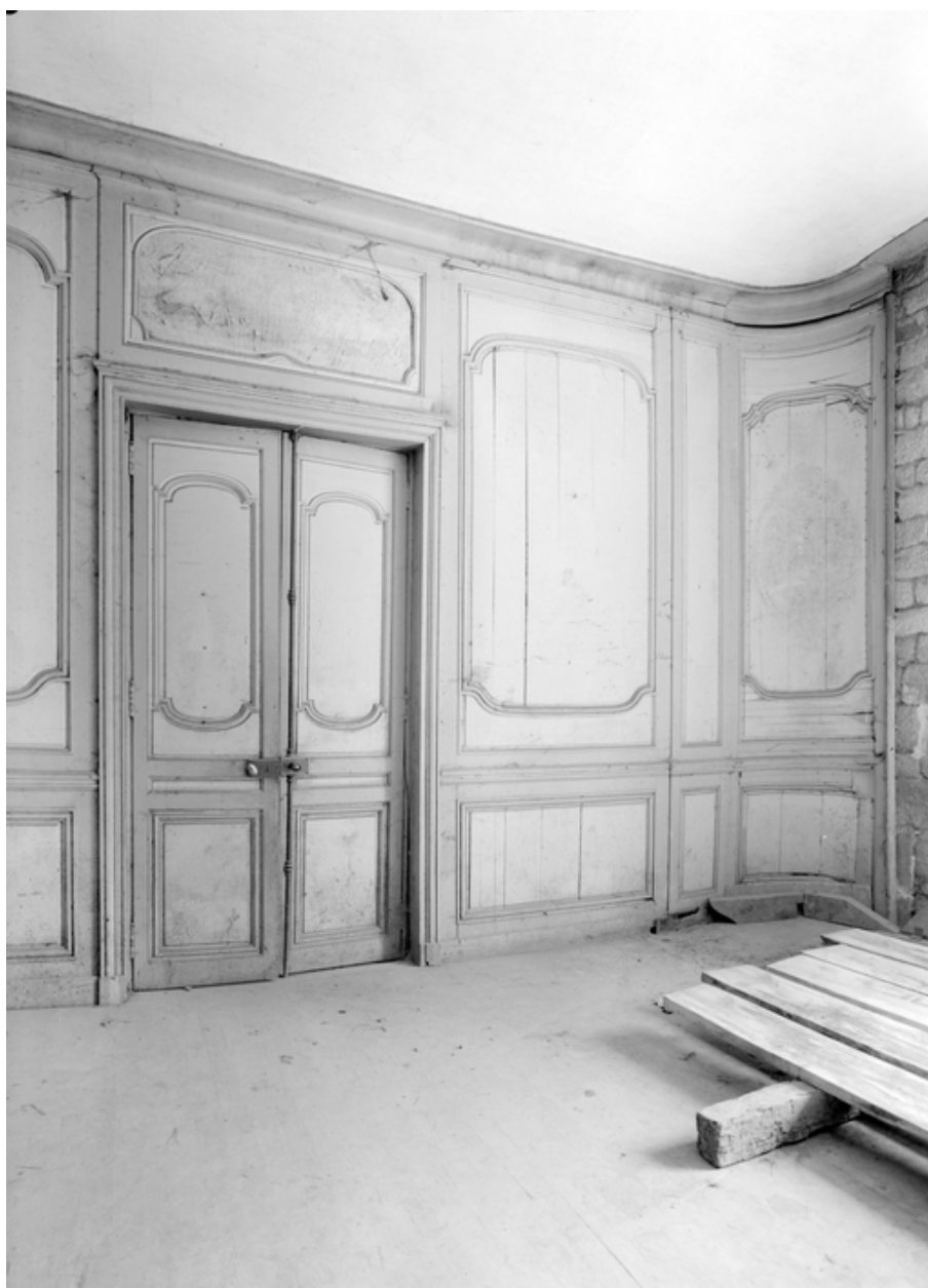
Aile ouest, pièce 2, lambris et porte de communication avec la pièce 1, état en 1967
