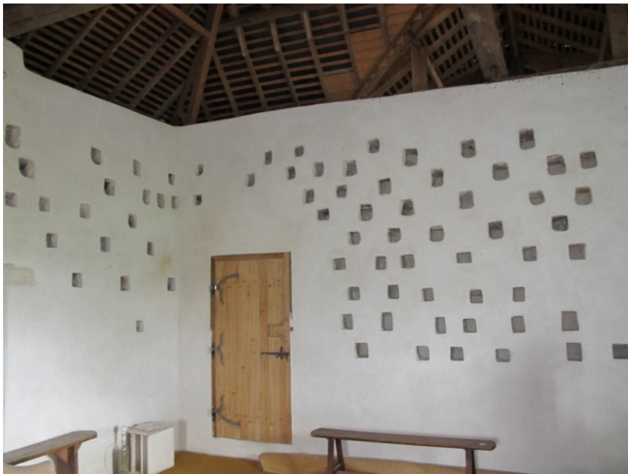
Partie ouest du bâtiment sud-ouest : ancien pigeonnier
