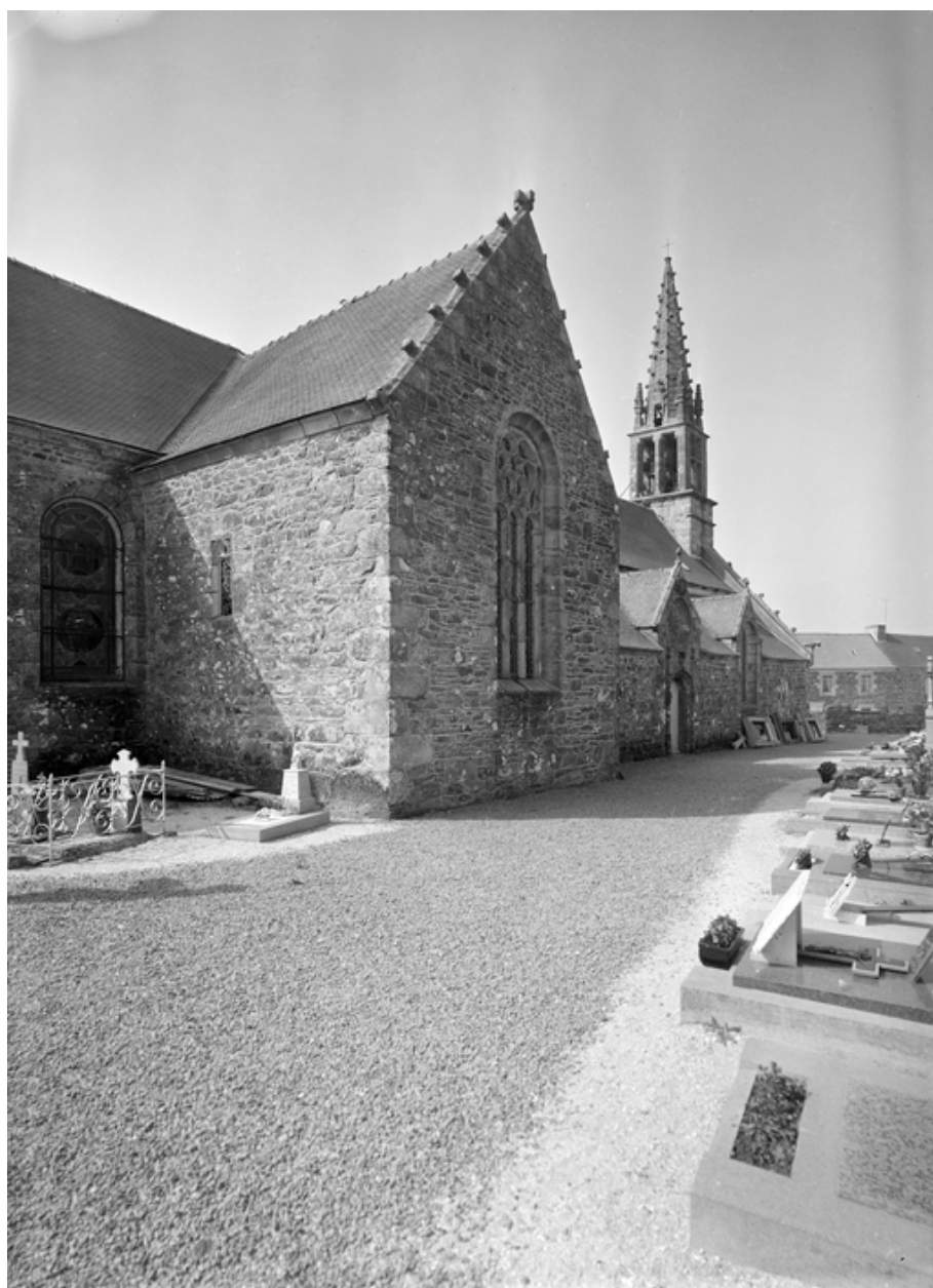
Vue générale nord
