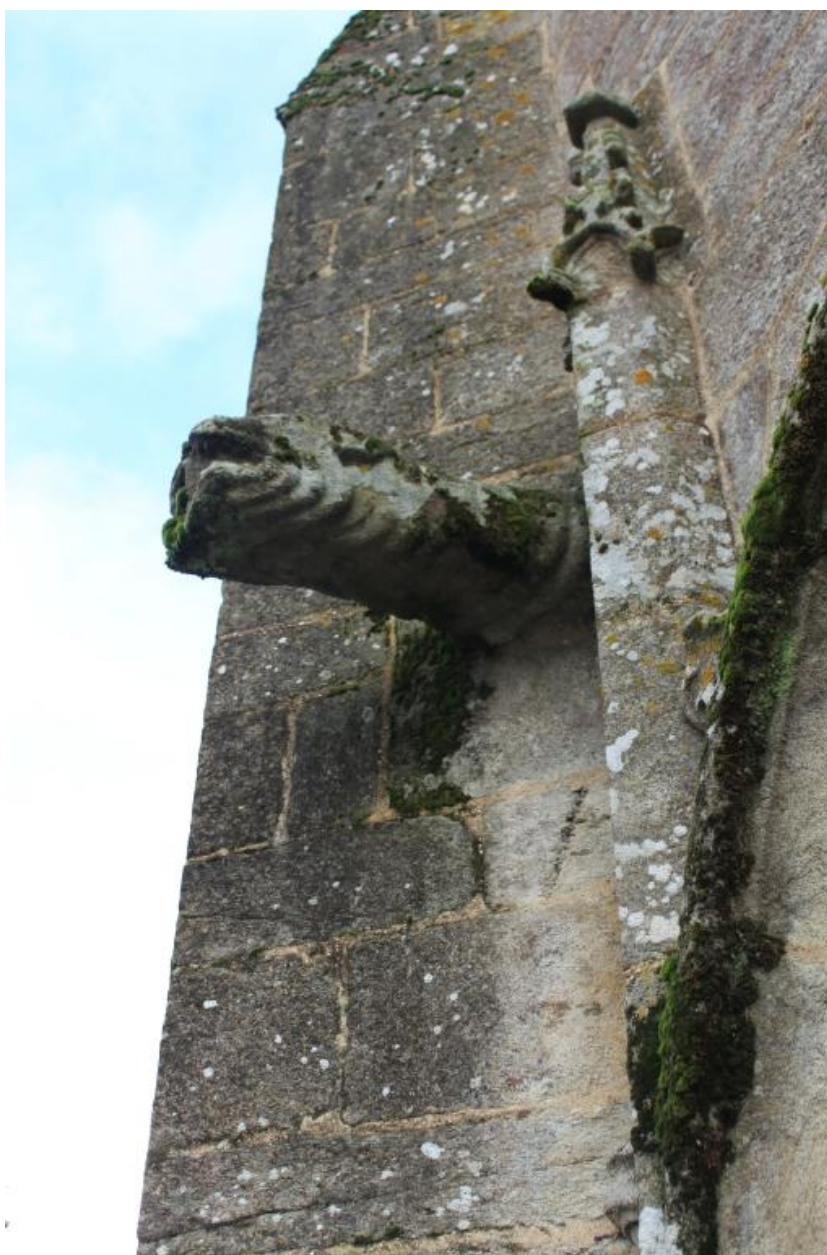
Eglise Saint-Mériadec de Stival, Pontivy, gargouilles portail ouest.
