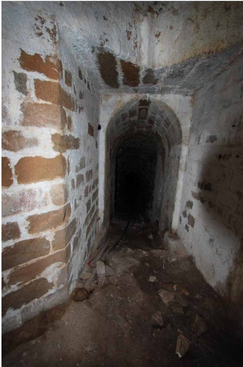
Saint-Pierre-Quiberon, fort de Penthievre, enceinte, casemates à feux de revers, accès à la galerie de mine en capitale.
